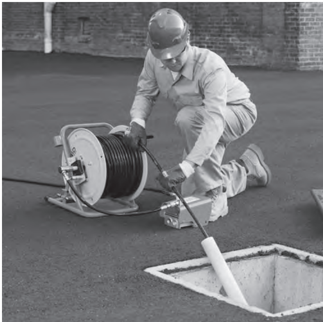
Kuva 10 – Viemäriaukon jatkaminen käyttöpisteeseen
