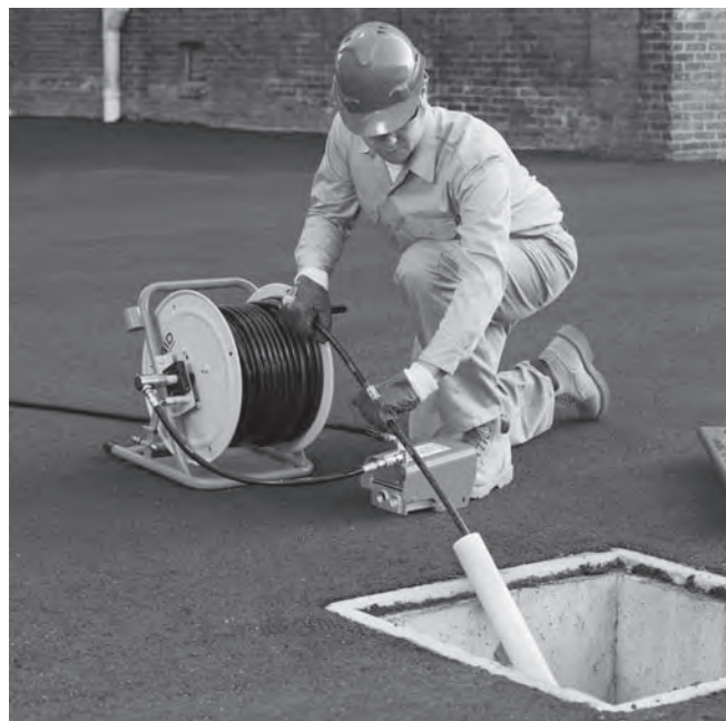
Figura 10 – Estensione dell'apertura della condotta al punto operativo
