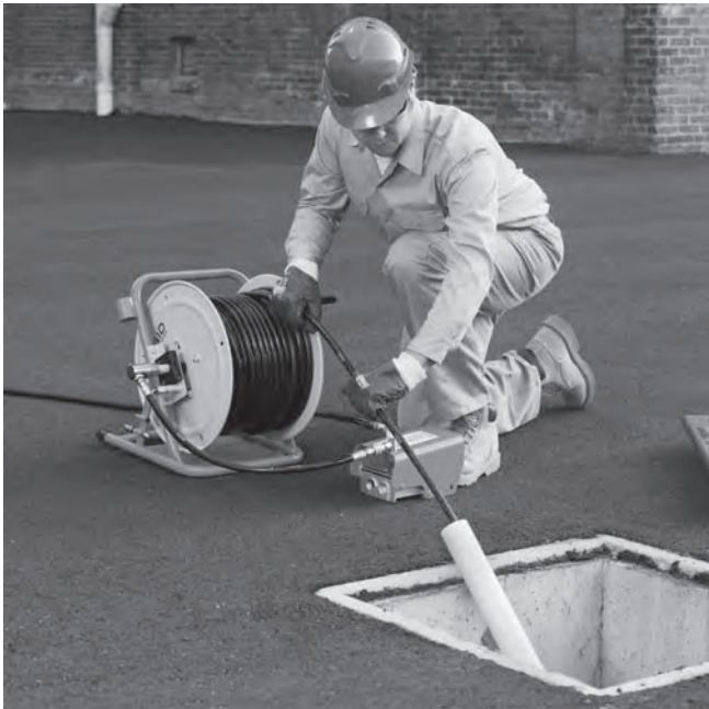
Figur 10 – Utvide avløpsåpningen til brukspunktet
