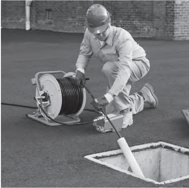
Abbildung 10 – Verlängern der Rohrleitungsöffnung zum Betriebspunkt
