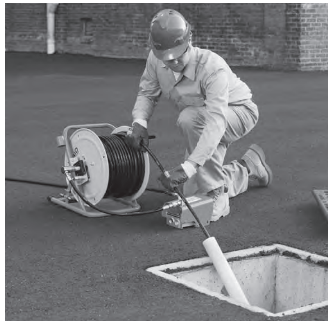
Rysunek 10 – Przedłużenie odpływu do punktu roboczego
