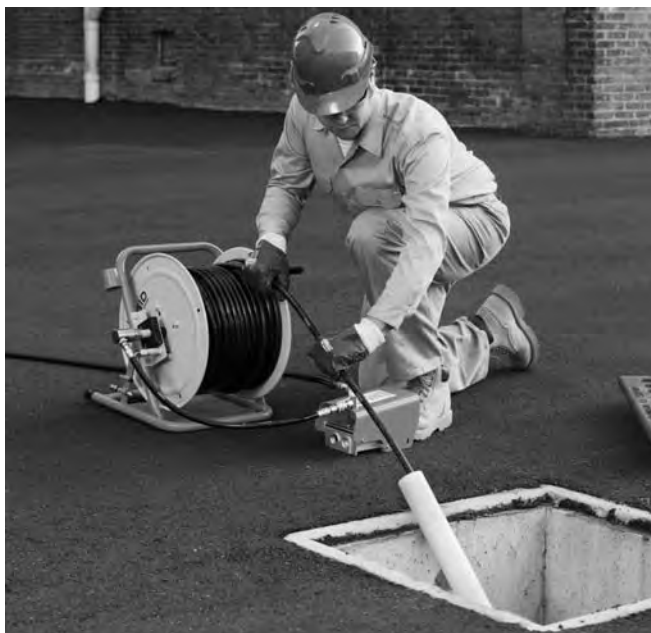
Figura 10 – Uso de un tubo-guía de manguera cuando se la interna por un gran acceso
